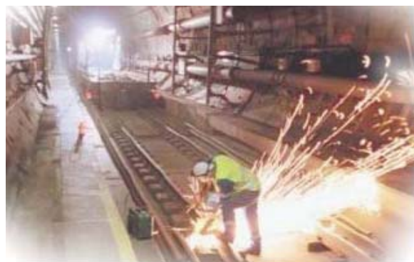
Плавный пуск для насосов откачивания воды Европейского туннеля (под проливом Ламанш).
